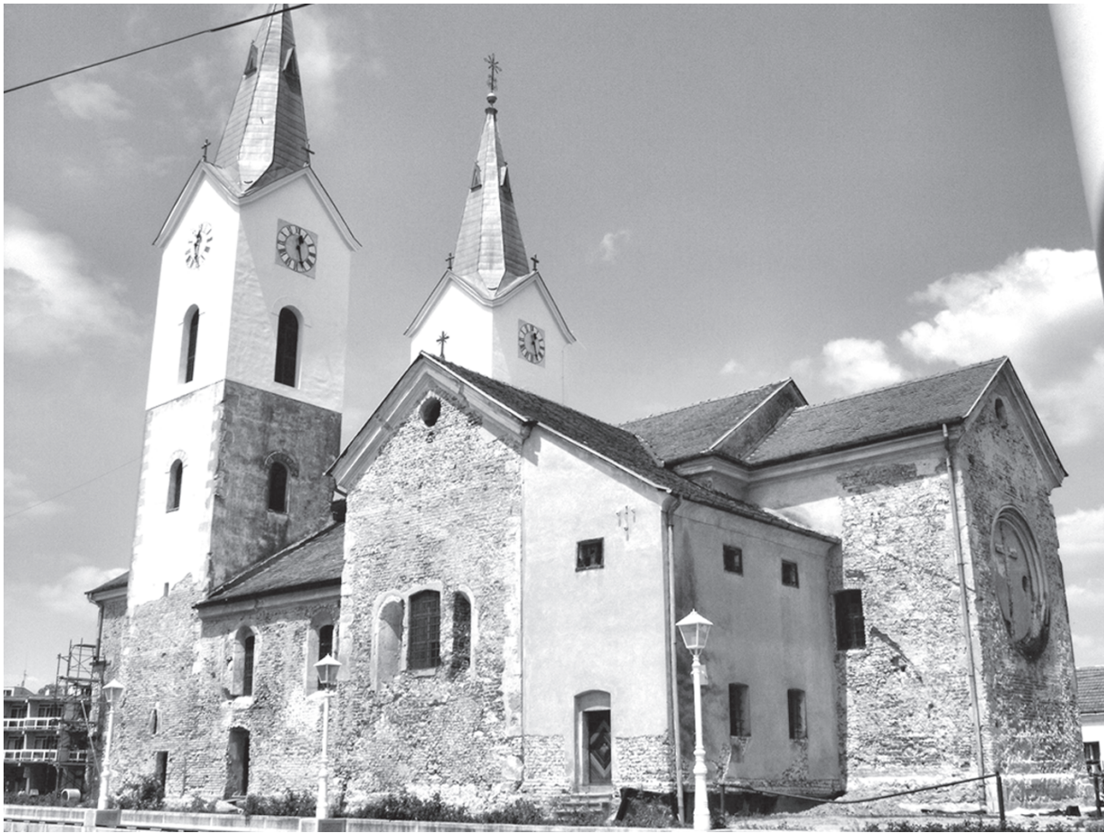
20. Negdašnja dominikanska crkva u Čazmi, pogled s jugoistoka (stanje 2003.) / Former Dominican church in Čazma, from the southeast (2003.)
