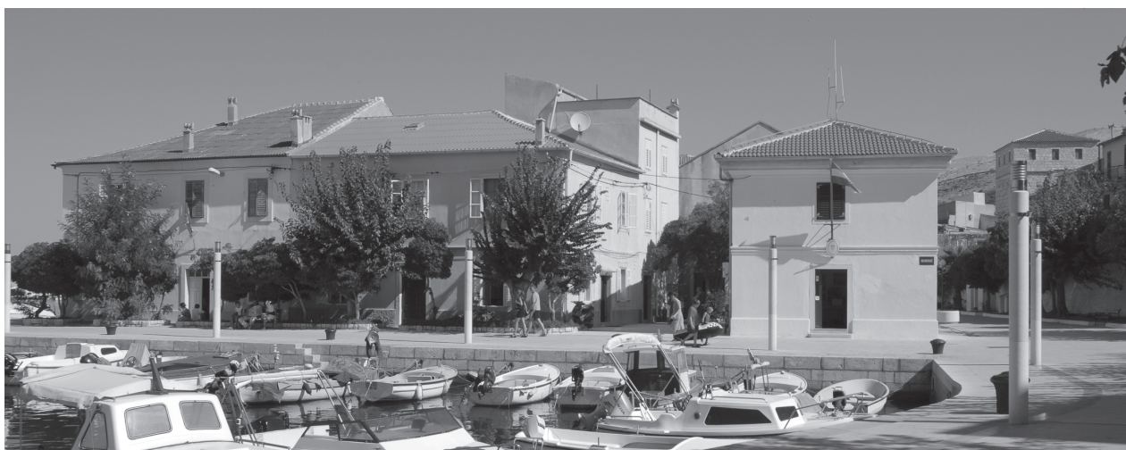
Pogled na Općinski sud i Lučku kapetaniju. (foto: M. Drmić) / View of Municipal tribunal and of Harbor master's office. (photo: M. Drmić)
