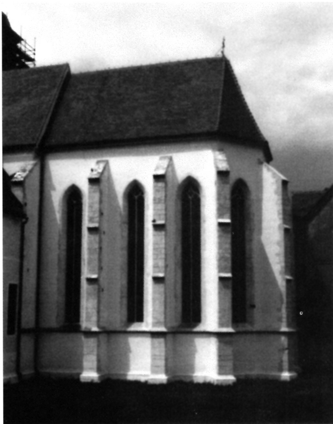
10. Svetište crkve nakon zaštitnih radova, Lepoglava, foto: M. Zadnikar
