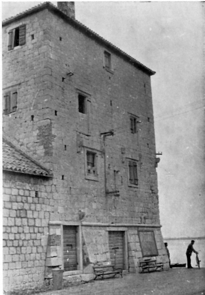
KAŠTEL CIPICO U KAŠTEL NOVOM, SJEVERNO PROČELJE (Foto: D. Diana)
