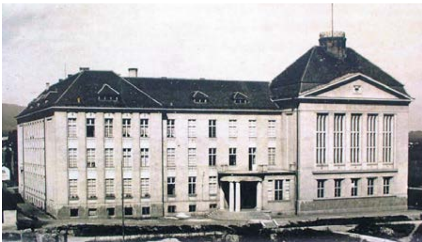
Sl. 9 Zgrada dekanata (bivša gimnazija) (Vladimir Dugački, arhiva)
