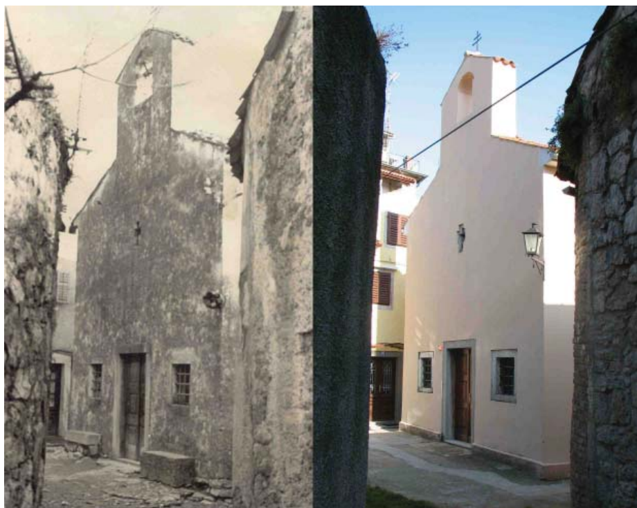
Slika 1. Pročelje crkve Sv. Ivana, lijevo prije obnove i desno nakon obnove
