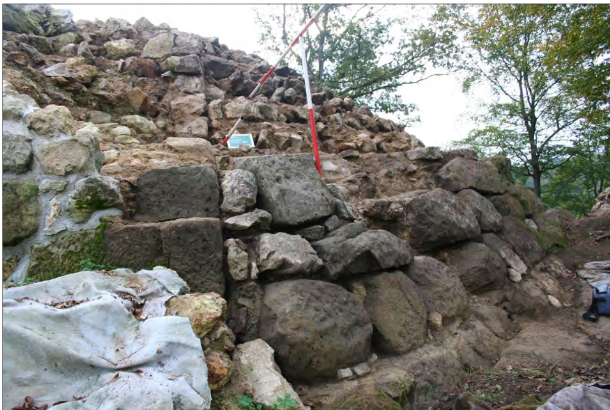
Sl. 6 Lijevo linija zida SJ 061, a desno aneksirani (?) šilj kule; vidi se da je SJ 061 u donjem dijelu građen od pravilnih, bosiranih klesanaca, a SJ 196 od golemih, ukoso polaganih gromada kamenja; sprijeda lijevo pogled na dio zida SJ 190; sve pogled od zapada (snimila: T. Tkalčec).
