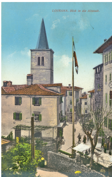
Slika 4. Motiv Lovrana s kućnim brojem L1/1/1 u prvome planu
