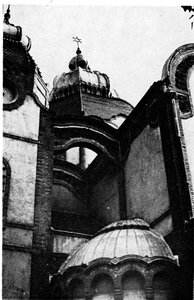
D. Jakab — M. Komor, SINAGOGA, Subotica (1902), detalj Foto: I. Stojko
