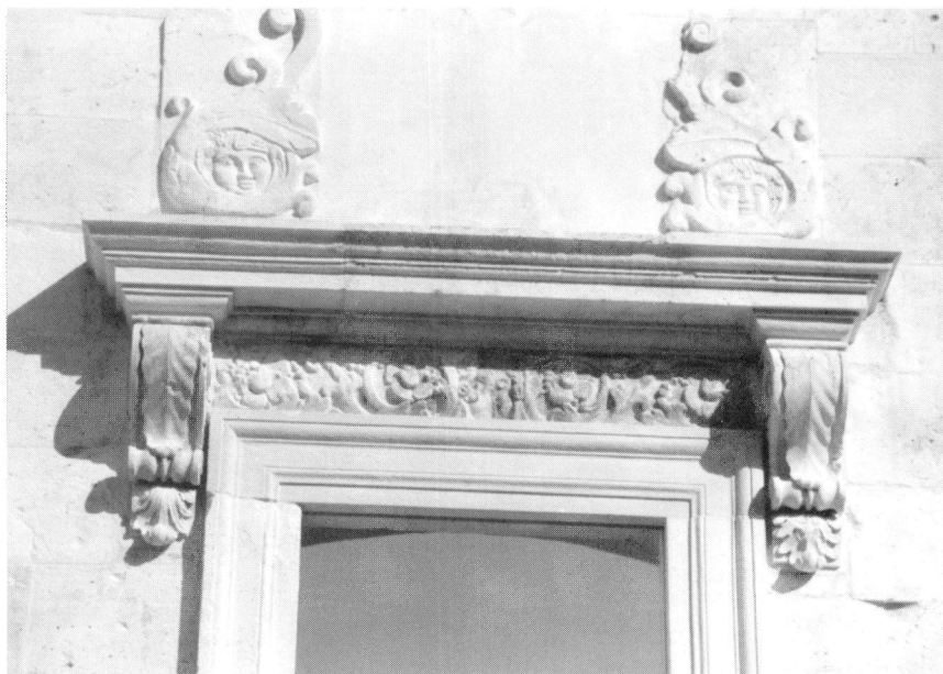
Zadar, Crkva sv. Šimuna, pročelje, dio prozora
