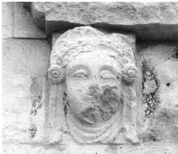
Zadar, Crkva sv. Šimuna, pročelje, dio prozora
