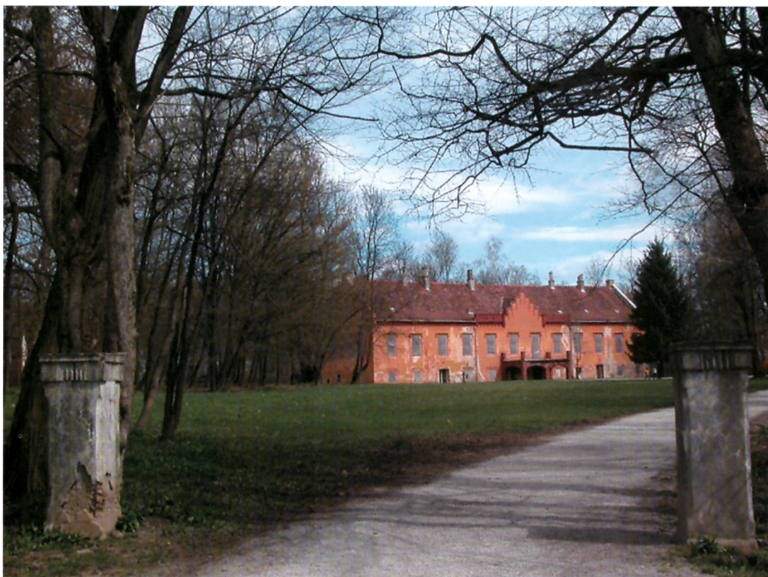
Dvorac s perivojem, pogled na južno pročelje, današnje stanje
