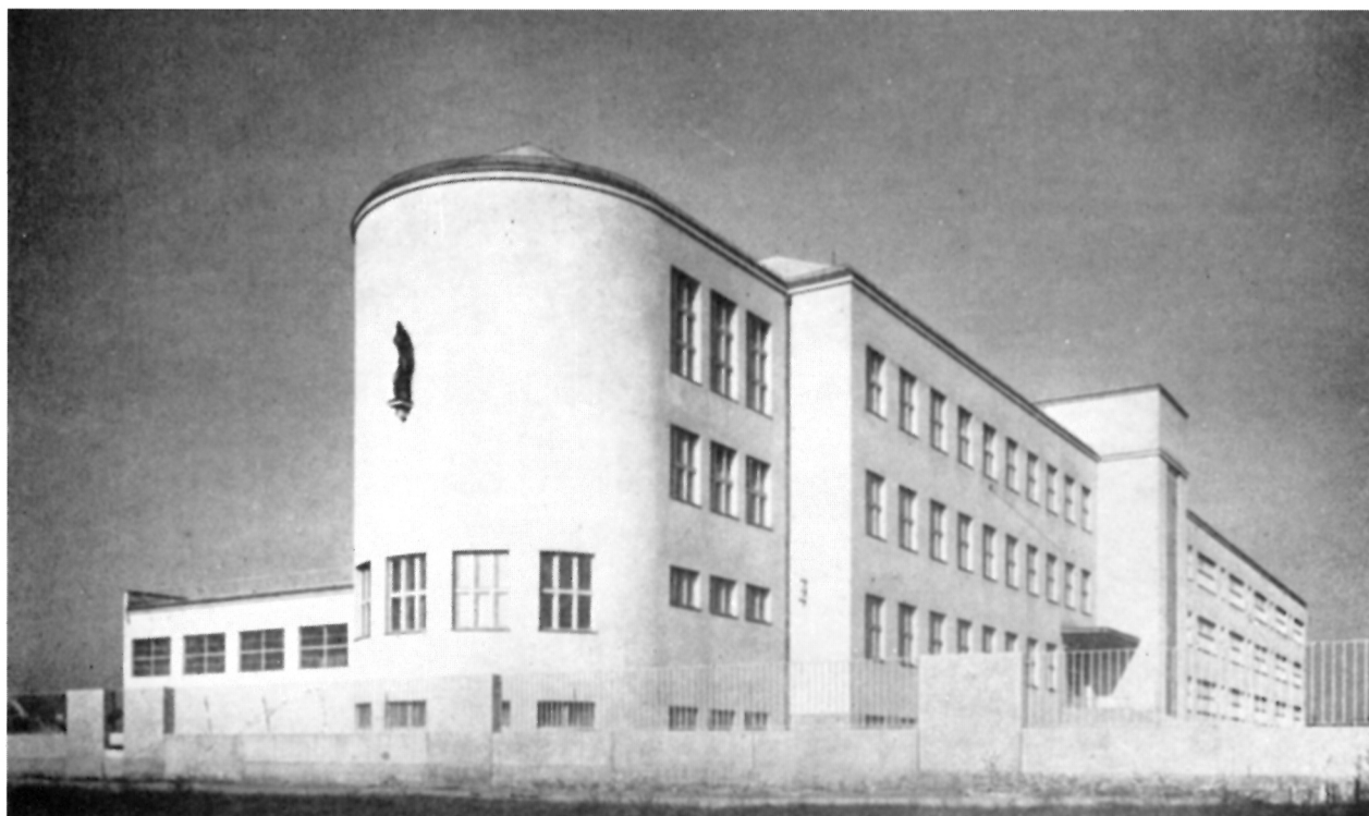
2. Novogradnja gimnazije u Kušlanovoj ulici u Zagrebu – situacija 1935. godine (izvor: Državni arhiv u Zagrebu)
