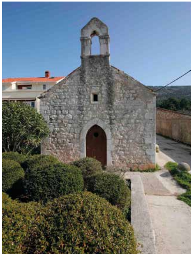
3 Kapela sv. Marije Magdalene u Cresu, pročelje (foto: D. Krizmanić, 2013., fototeka KOR)
