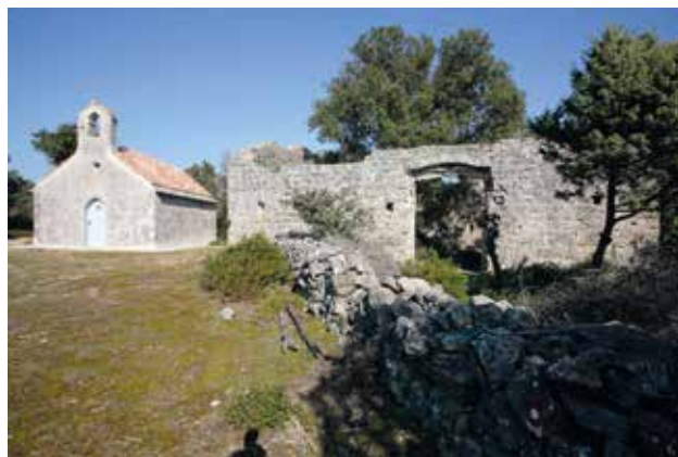
12 Vlastelinski posjed obitelji Bochina, Parhvac (foto: D. Krizmanić, 2013., fototeka KOR)
