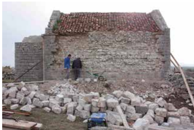
18 Kapela sv. Petra u Hrasti, obnova (foto: D. Krizmanić, 2012., fototeka KOR)
