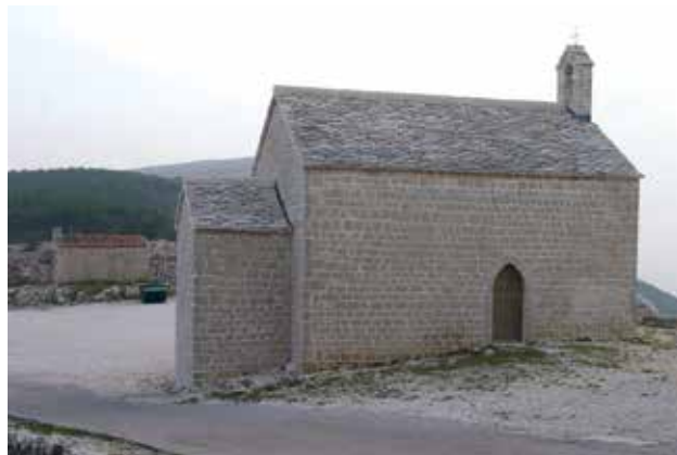
16 Kapela sv. Antuna u Lubenicama, stanje nakon obnove (foto: D. Krizmanić, 2005., fototeka KOR)
