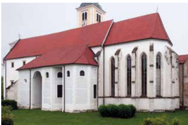
5 Pogled na crkvu s jugoistoka, s gotičkim svetištem i baroknim kapelama prigradenim uz južni zid (foto: G. Tomljenović, HRZ, 2015.)
