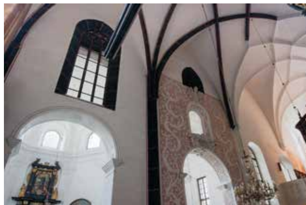
8 Gotički prozori lađe crkve prekinuti probijanjem kapela na južnom zidu (foto: G. Tomljenović, HRZ, 2015.)
