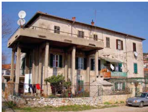
21 Upravna zgrada nekadašnje tvornice u Crnici, današnje stanje (foto: I. Šprljan)
