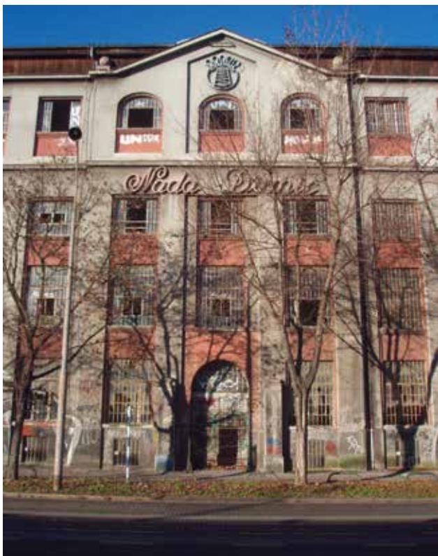
13 Detalj glavnog pročelja tvorničke zgrade (foto: M. Pretković, 2014.) Detail of the factory building main facade (photo: M. Pretković, 2014)
