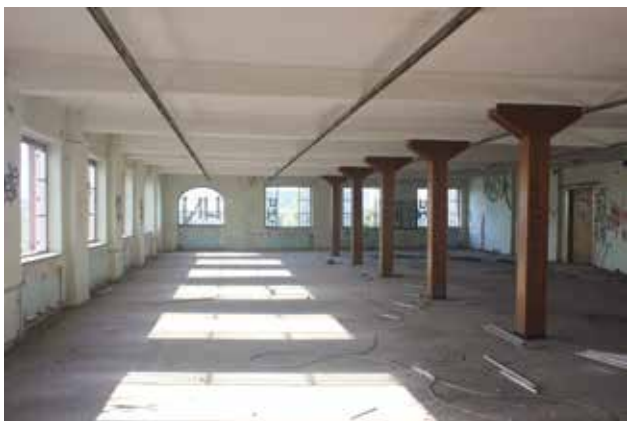
20 Tvornička hala u ugaonom dijelu zgrade na 3. katu (foto: M. Pretković, 2013.)
