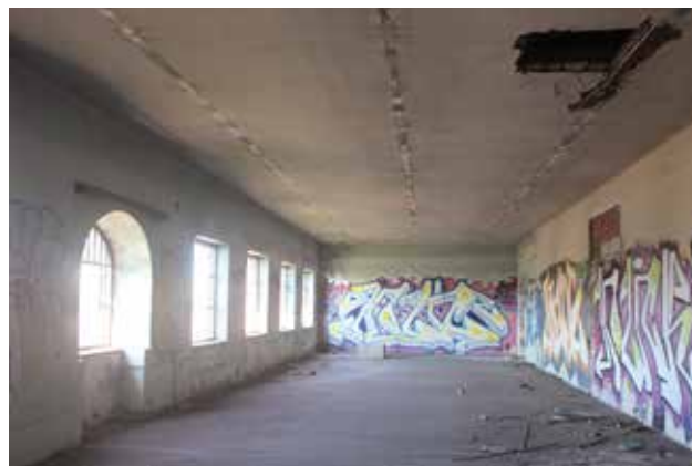
22 Tvornička prostorija na 3. katu s pogledom na Branimirovu ulicu (foto: M. Pretković, 2013.)
