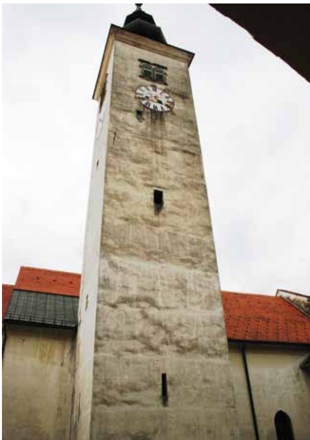
15 Pogled na pročelja zvonika crkve sv. Martina biskupa u Varaždinskim Toplicama prije obnove, stanje 2010. godine (foto: M. Korunek)
