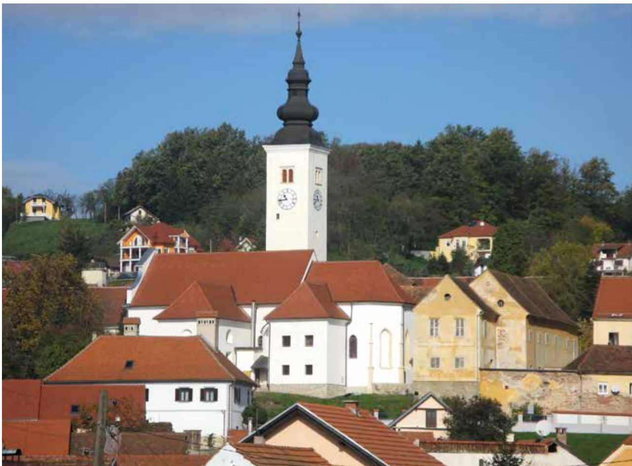
24 Pogled na obnovljena vanjska pročelja crkve sv. Martina biskupa u Varaždinskim Toplicama, stanje 2012. godine (foto: Ž. Trstenjak)
