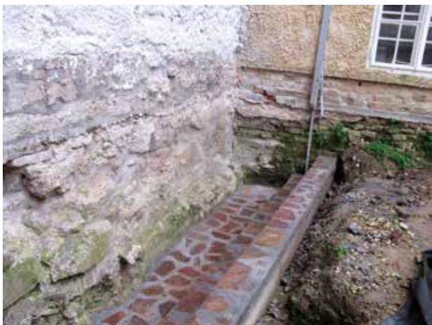
12 Potporni zid sa stubom izveden nakon sniženja terena uz donju zonu zidova lađe crkve sv. Martina biskupa u Varaždinskim Toplicama, stanje tijekom radova 2010. godine (foto: M. Korunek)
