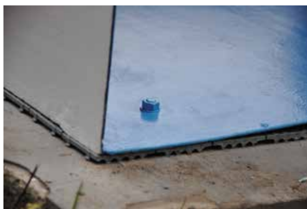
19 Detalj vodopropusne podloge koja je postavljena ispod skulpture (foto: S. M. Sunara, 2014.) Detail of the water permeable base under the sculpture (photo: S. M. Sunara, 2014)
