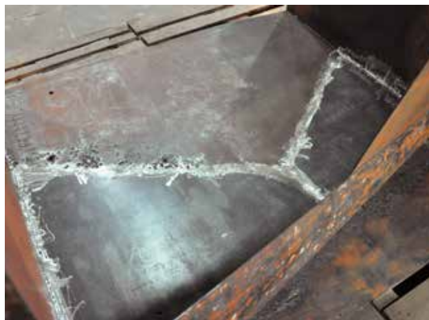
14 Podnica nakon umetanja nedostajućih dijelova i obrade varnih spojeva (foto: S. M. Sunara, 2014.)
