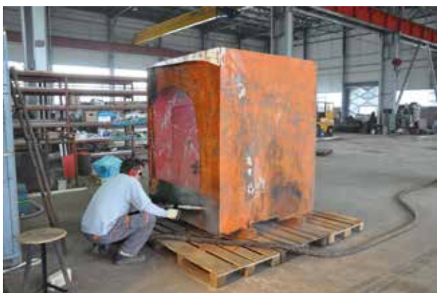
13 Odstranjivanje premaznih slojeva do prvog sloja temeljnog premaza metodom čišćenja suhim ledom (foto: S. M. Sunara, 2014.) Removal of coating layers up to the first layer of primer by dry ice blasting method (photo: S. M. Sunara, 2014)
