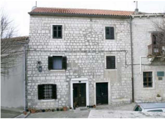
7. Biskupski dvor, istočno krilo s tragovima pregradnji gotičkih otvora (foto: D. Krizmanić, izvor: Fototeka Konzervatorskog odjela u Rijeci) Episcopal Palace, east wing with the traces of remodellings of Gothic openings
