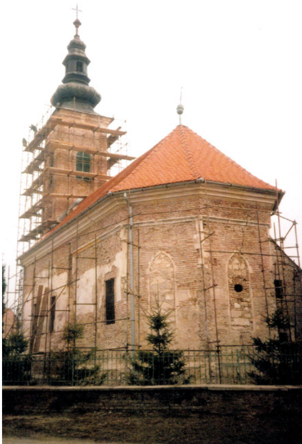
6. Pogled na svetište i južni zid lađe, stanje nakon uklanjanja žbuke s vanjskih pročelja 1980-ih godina (dokumentacija RKT župe sv. Jakoba u Prelogu)
