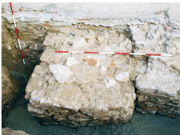
9. Kontrafor južnog zida svetišta s dozidanom strukturom (fototeka Arheološkog odjela Muzeja Medimurja Čakovec, snimila B. Marcioš, 2009.)
