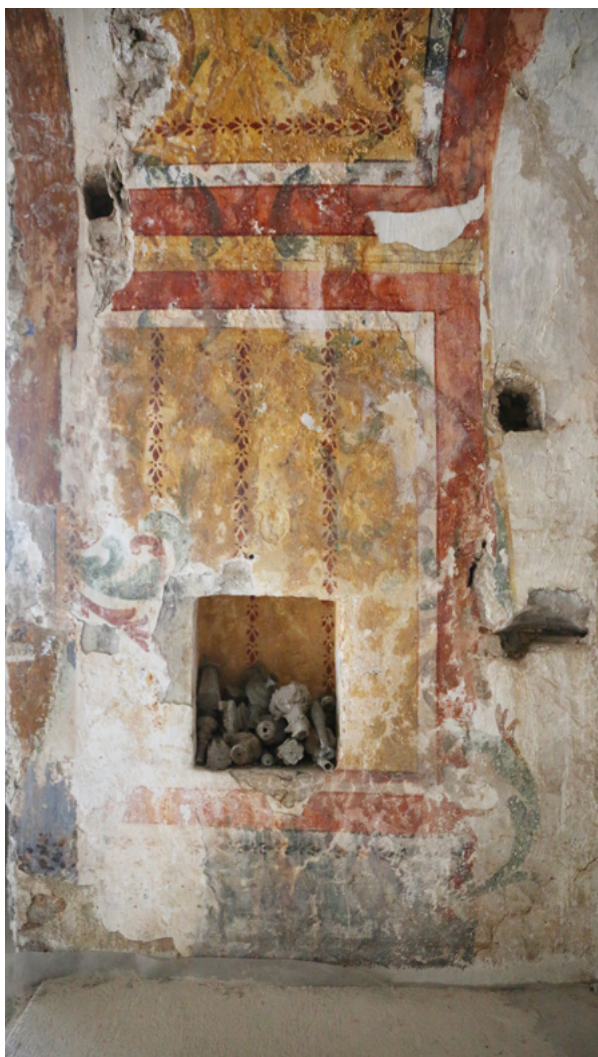
8. Apsida, sjeverni zid – otvori u zidu, uporišta oltara (snimio L. Piplica, 2014.) Apse, north wall – openings in the wall, altar footings (photo by L. Piplica, 2014)
