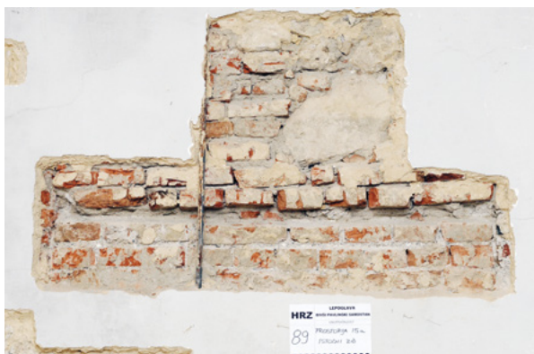
15. Sonda s vidljivim tragovima pete svoda: nizovi opeke slagani ukoso prema gore (donja strana sonde), prekid u kontinuitetu građe te rahla mješovita građa gornjeg dijela koja predstavlja popravak nakon izbijanja dijelova svodne konstrukcije iz zida (fototeka HRZ-a, snimio J. Škudar, 2014.)
