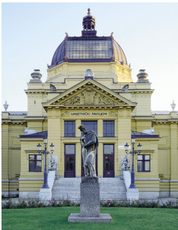
27. Srednji dio sjevernog pročelja, 1998. (snimio D. Fabijanić) Central portion of the north front, 1998 (photo by D. Fabijanić)
