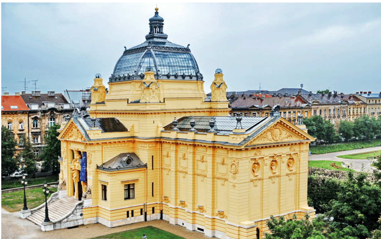
29. Umjetnički paviljon nakon obnove, 2013. (snimio M. Perušić) Art Pavilion after renovation, 2013 (photo by M. Perušić)
