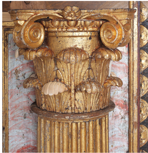
7. Detalj lijevog kompozitnog kapitela glavnog oltara Uznesenja Marijina, nakon uklonjenog alteriranog laka i rekonstrukcije oštećenja drvenog nosioca (fototeka HRZ-a, snimio G. Tomljenović, 2014.)
