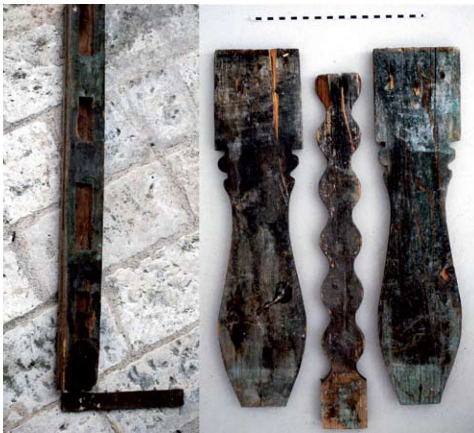
Slika 9. Dio rukohvata (lijevo) i dijelovi balkonske ograde (desno) palače Gligo (snimio D. Čikara, 2012.)
