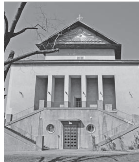
SL. 2. CRKVA SV. ANTUNA NA ŠALATI, IZVANJA FIG. 2. CHURCH OF ST ANTHONY, ŠALATA, EXTERIOR
