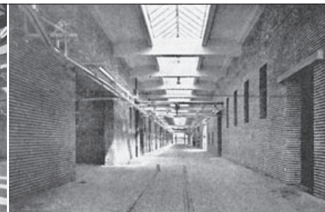
SL. 12. KLAONICA, INTERIJER, IZVORNO STANJE FIG. 12. MEAT PACKING PLANT, INTERIOR, ORIGINAL CONDITION
