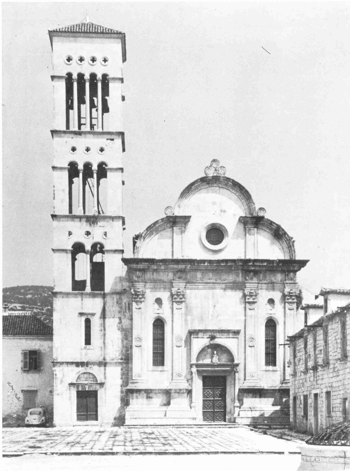
21. Pročelje i zvonik hvarske katedrale (foto K. Tadić)
