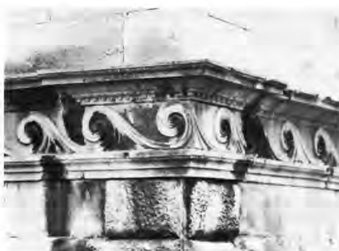
7. Gundulićeva palača, detalj vijenca između prvog i drugog kata (snimio K. Tadić)
