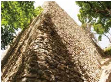
Slika 11. Južni i istočni zid kapele utvrde Grebengrad, stanje nakon obnove (foto: Marijana Korunek, 2014.g., KOVŽ)
