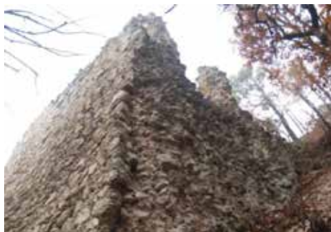
Slika 10. Južni i istočni zid kapele utvrde Grebengrad, stanje prije obnove (foto: Marijana Korunek, 2009.g., KOVŽ)
