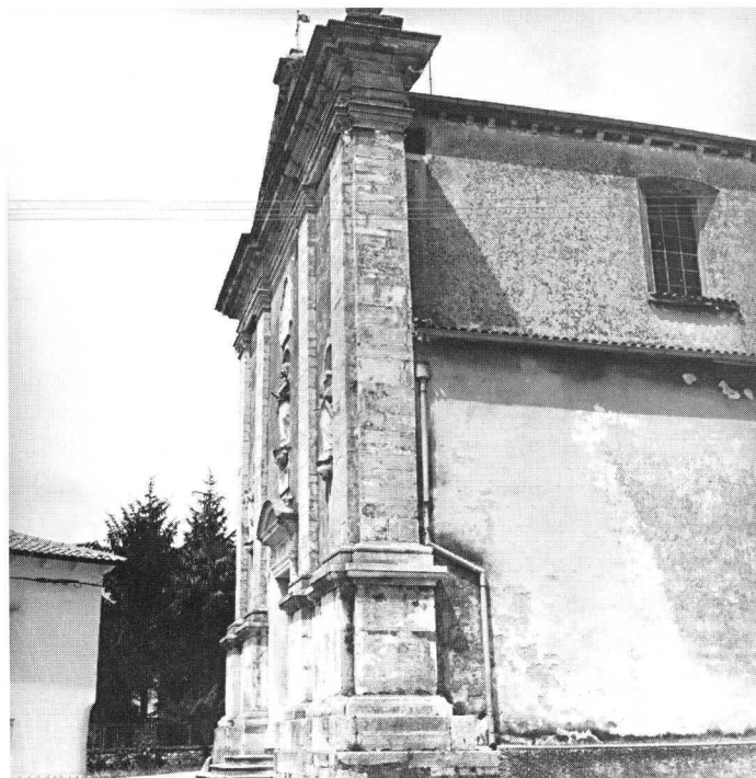
3. Župna crkva, Tinjan, pogled na pročelje
