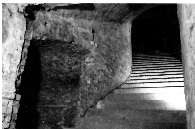
9. Spoj manje podrumске prostorije i novog, zavinutog stubišta, Kaptol 24
