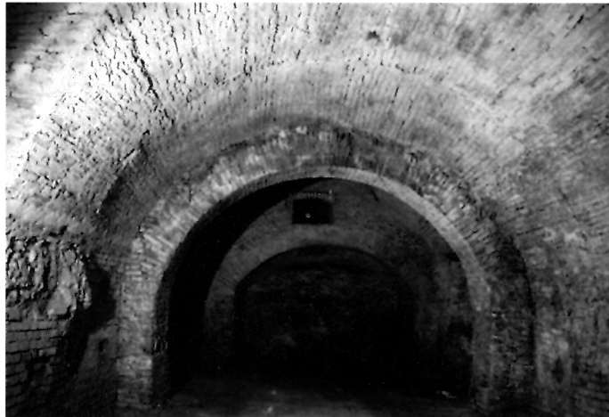
10. Pogled prema južnom zidu velike prstorije, naknadno proširenom nišom. Sprijeda lijevo vidi se krupno lomljeno kamenje starih temelja i na svodu reška ispred pojasnice, Kaptol 24
