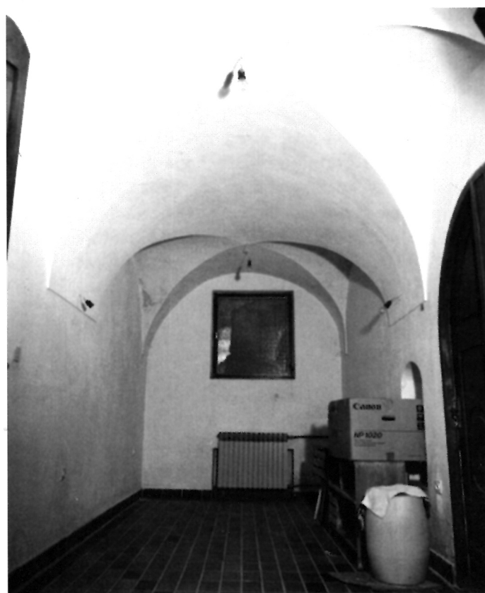
4. Svod pročelne podrumske prostorije, pogled prema zapadnom zidu, Kaptol 20
