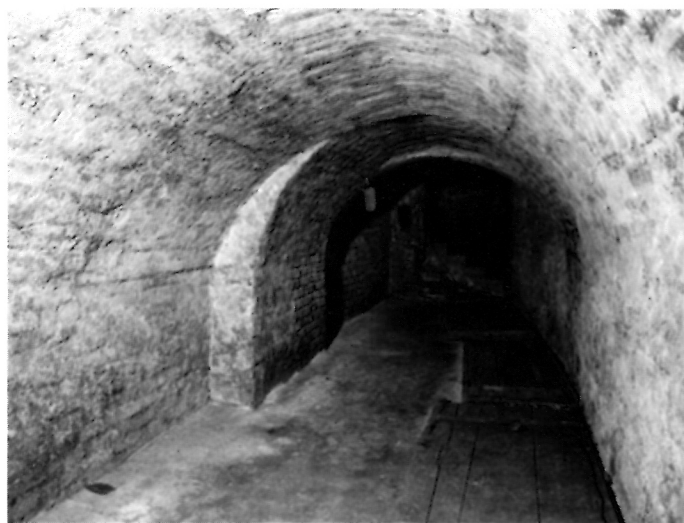
8. Mala zakrivljena prostorija, pogled prema jugu. U prednjem planu vidi se pojasnica svoda, u stražnjem novo stubište, Kaptol 24
