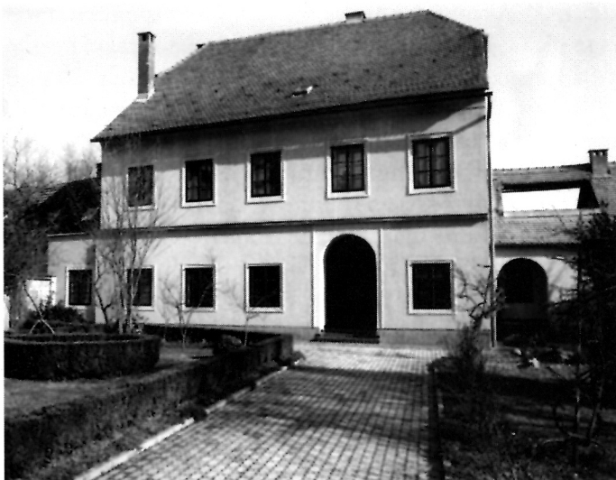
1. Ulazno pročelje kurije, Kaptol 20, Zagreb
