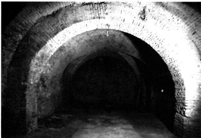
7. Pogled prema sjevernom zidu velike podrumске prostorije. U pozadini se vidi par trokutastih susvodnica i s lijeve strane otvor prema starom stubištu, Kaptol 24
