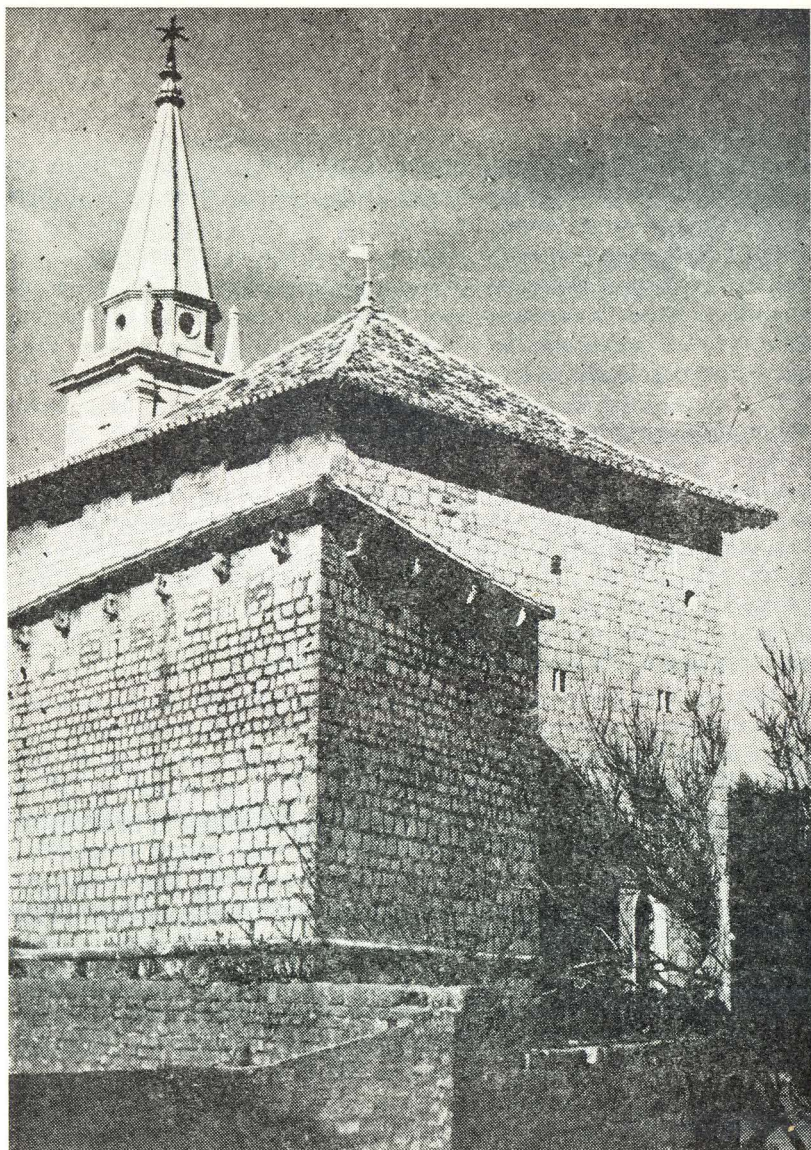
»Vela kula« i bastion crkve-tvrđave u Jelsi (pogled sa jugoistoka)
