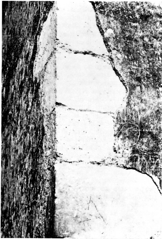
1 Gornje Psarjevo, detalj s glavnog pročelja crkve sv. Jurja
