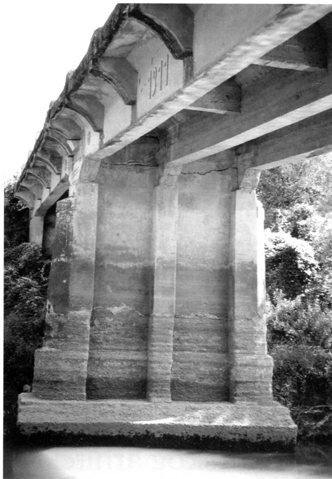
Most na Dravskoj Kopitnici, pogled na pilone i grede
