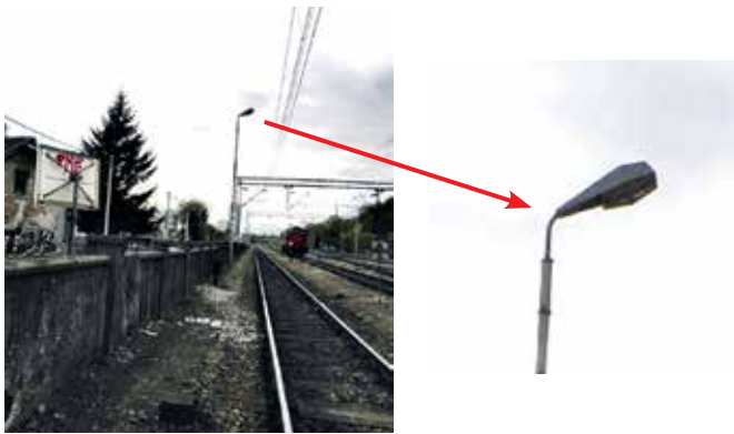
Slika 3. Zastarjela rasvjeta prilazne zone
