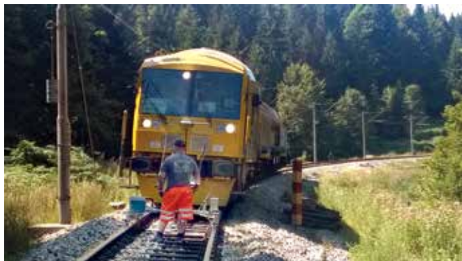
Slika 8: Korištenjem vlaka za glodanje na pruzi koja ima više od 90 km dokazano je povećanje razine sigurnosti i kvalitete željezničke infrastrukture (izvor: Vossloh).
