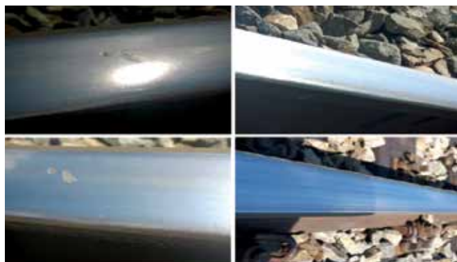
Slika 10: Primjer stanja tračnice prije i nakon korištenja vlaka koji je izveo glodanje 4. kolovoza 2015. na dionici između Moravica i Skrada (izvor: Vossloh)
