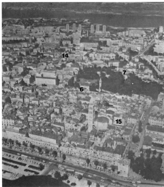
73. Snimak Splita iz zraka. U prednjem planu je povijesna jezgra 15, desno dio istočne strane nekadašnjeg obrambenog prostora, a u bližoj pozadini sjeverna strana obrambenog prostora u kojem se ističe današnji gradski park (7).
