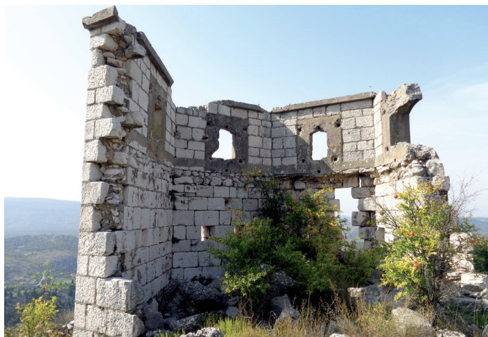
Unutarnji zarušeni dio stražarske utvrde na Komanjem Brdu
