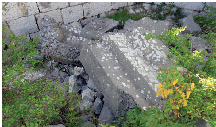
Zarušeno stepenište u unutrašnjosti utvrde na Komanjem Brdu
