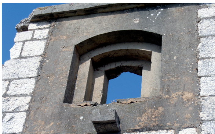
Otvor za osmatranje na Wachhaus Komanje Brdo
