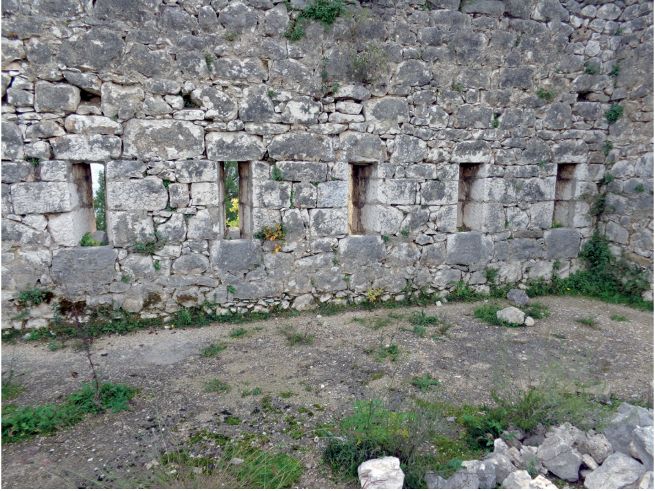
Puškarnice na zidu utvrde
