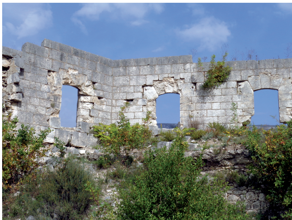
Pogled na toparnice iznutra
