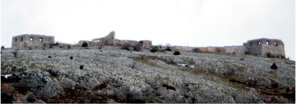
Ostatci utvrde Werk Gradina
