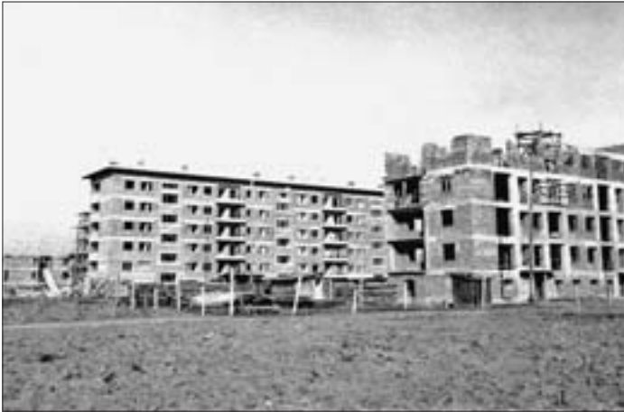
SL. 27. M. ŽERJAVIĆ: PET VIŠESTAMBENIH ZGRADA U ULICI GRADA VUKOVARA U IZGRADNJI SREDINOM 1950-IH FIG. 27 M. ŽERJAVIĆ: FIVE APARTMENT BLOCKS IN VUKOVAR STREET UNDER CONSTRUCTION, MID 1950S
