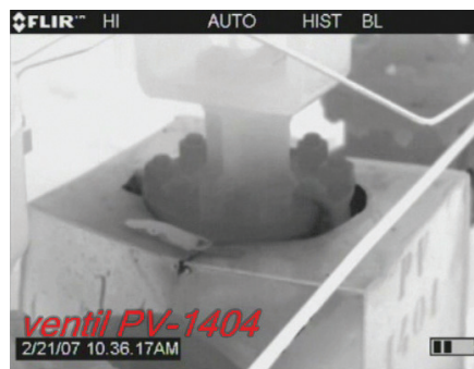
Slika 19 – Propust pri označenom ventilu
