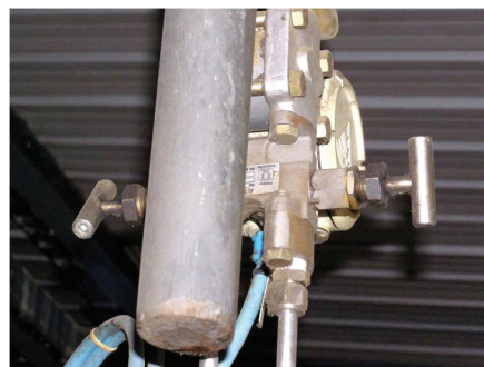
Slika 20 – Pozicije propusta ventila
