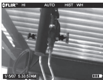
Slika 20 – Pozicije propusta ventila
