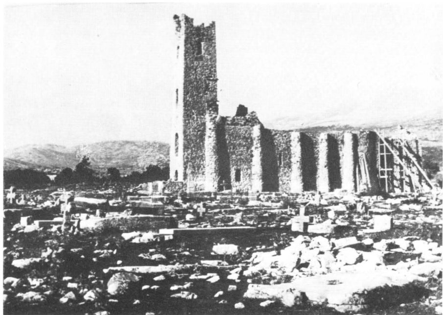
Sv. Spas: pogled na južni bočni zid crkve s ojačanim masivnim kontraforima
