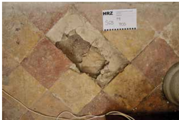
11. Sonda u podu sjeveroistočne prostorije prizemlja (Dokumentacija HRZ-a, snimila: N. Vasić 2012.) / Site exemplar on the floor of the northeast room of the ground floor (Documentation of the Croatian Conservation Institute, photo: N. Vasić, 2012)
