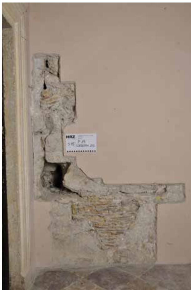
9. Sonda na sjevernom zidu saloče, mjesto nekadašnjega renesansnog pila (Dokumentacija HRZ-a, snimila: N. Vasić, 2012.) / Site exemplar on the north wall of the salon, formerly site of the Renaissance basin (Documentation of the Croatian Conservation Institute, photo: N. Vasić, 2012)
