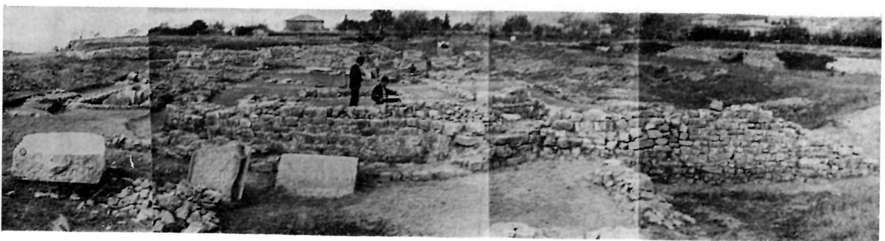
3 Kompleks prije konzervatorskih radova — pogled s istoka
