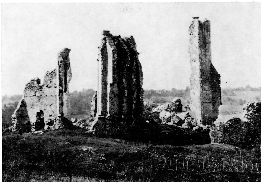
6 Pogled na ostatke zidova svetišta samostanske crkve u BIJELOJ 1899. g.; desno ostatak zapadnog pročelja, lijevo zid istočnog krila samostana (negativ u Republičkom zavodu za zaštitu spomenika kulture)
