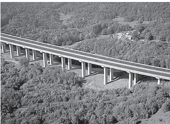
Slika 2. Vijadukt Jezerane – Ličko Lešće
