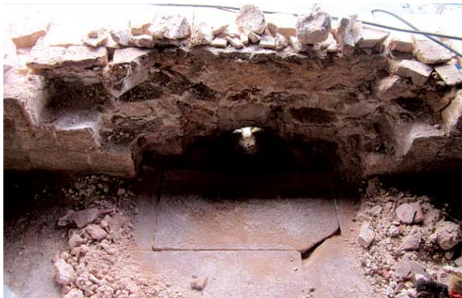
Demontaža dijela zida i pločnika koji zatvaraju korito vodorige unutar južne galerije
