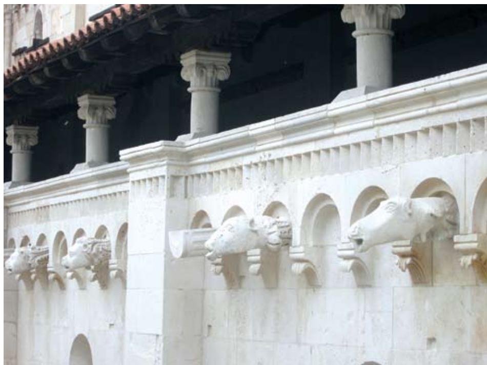
Glave vodoriga na južnoj galeriji Trogirске katedrale, nakon restauracije
