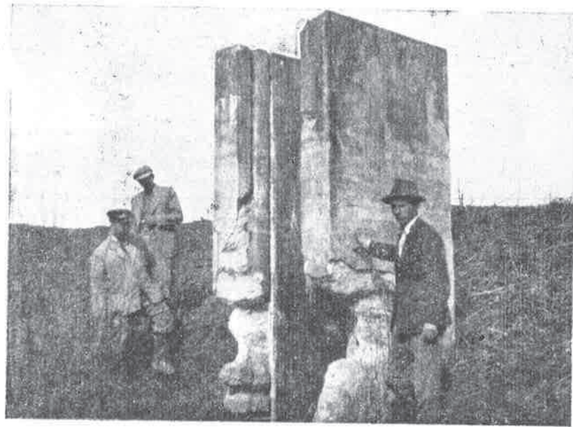
Oštećeni grljenak
