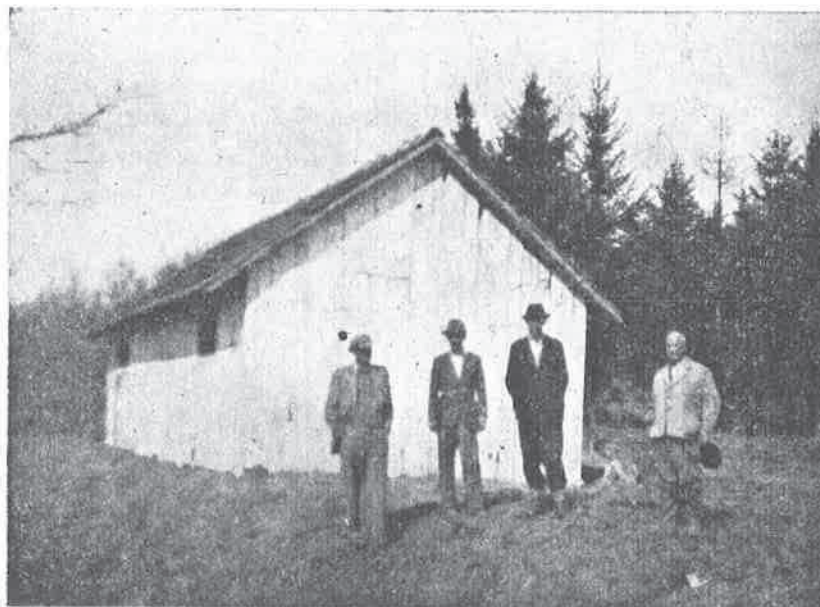
Prva baraka podignuta na radilištu
