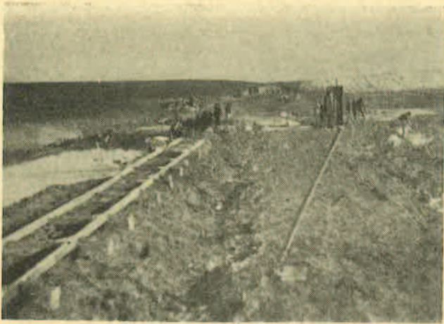
Gradnja pregradnog nasipa u dolu na upravi Grabovo Foto: Fijan
