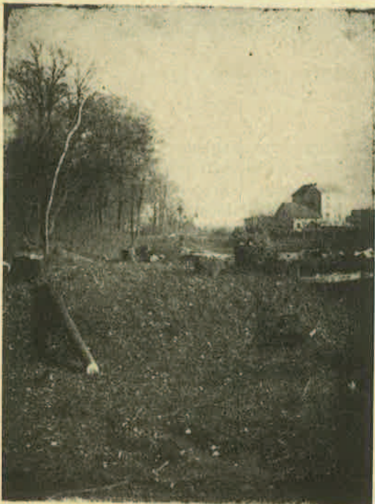
Na radilištu novog ribnjaka u Vel. Bukovcu Foto: Fijan
